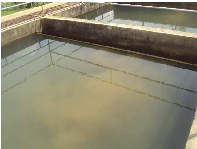
Figura 24 – ETA – Decantadores
