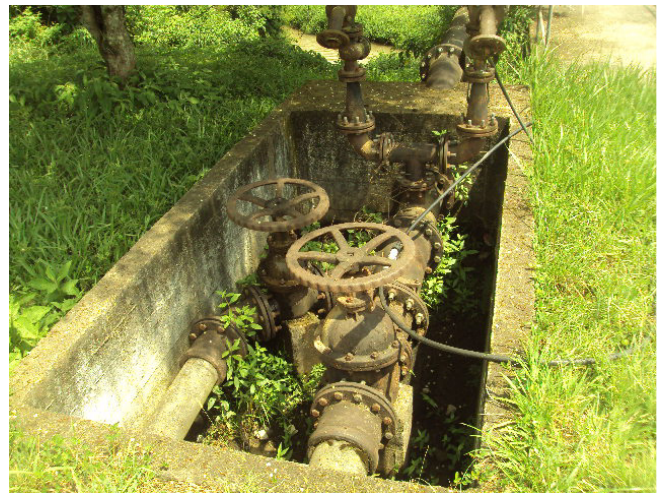
Figura 9 – Registros de manobras (captação)
