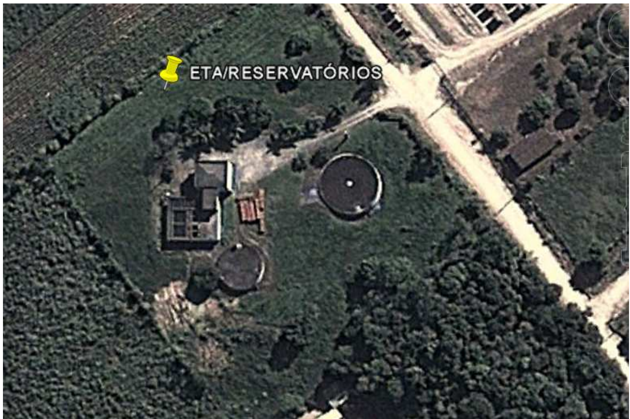
Figura 5 – Vista da ETA e reservatórios.
