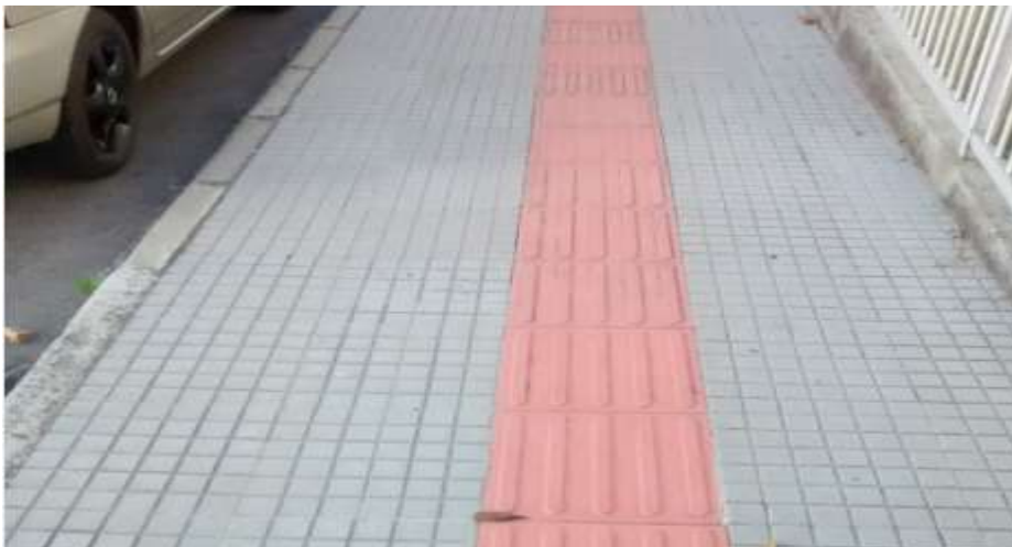
Figura 13 - Calçada com piso hidráulico.
