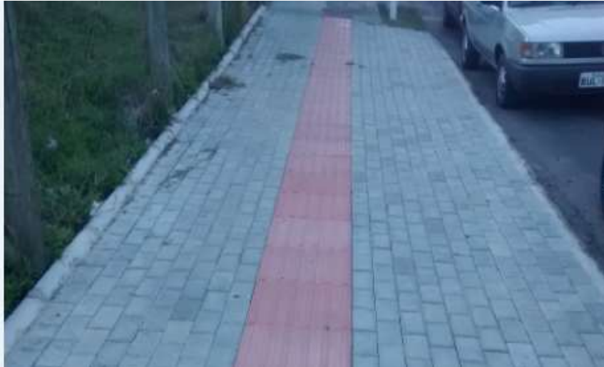
Figura 12 - Calçada em Paver.
