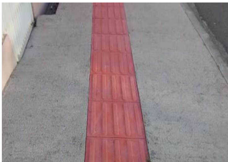
Figura 11 - Calçada em concreto.
