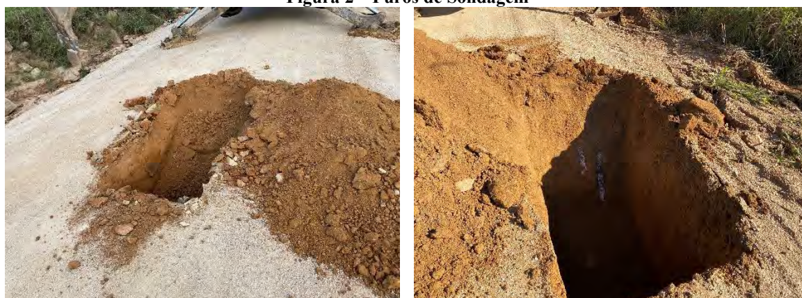
Figura 2 – Furos de Sondagem
