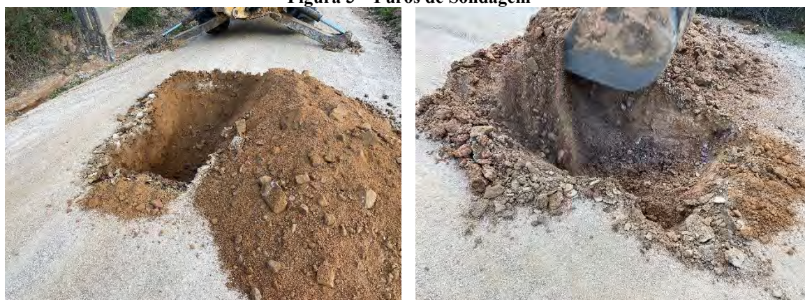
Figura 3 – Furos de Sondagem
