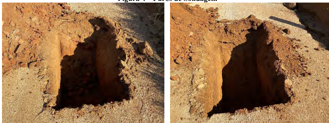
Figura 4 – Furos de Sondagem
