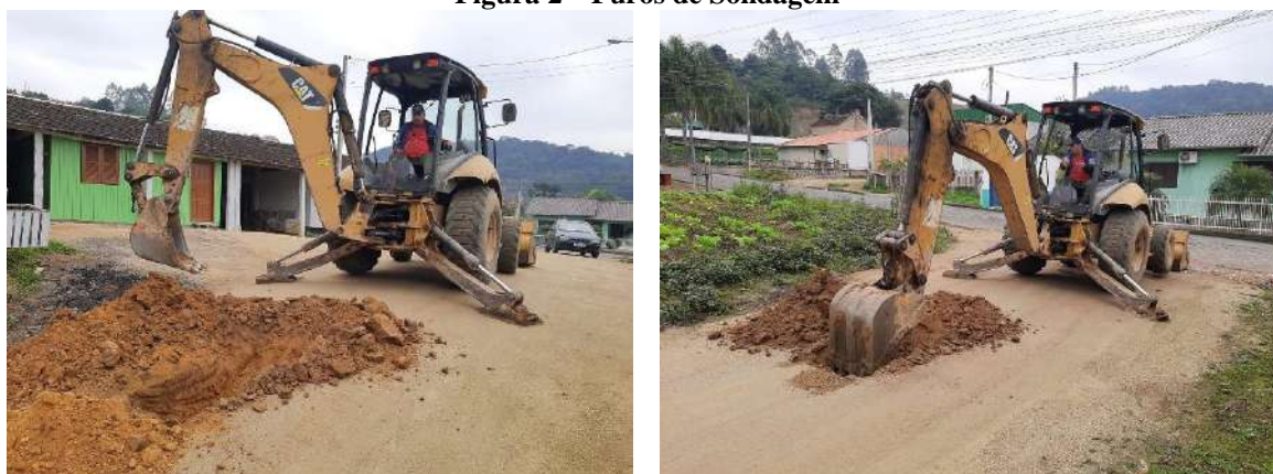
Figura 2 – Furos de Sondagem
