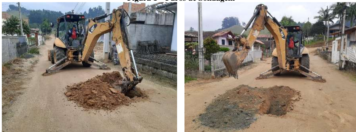
Figura 1 – Furos de Sondagem
